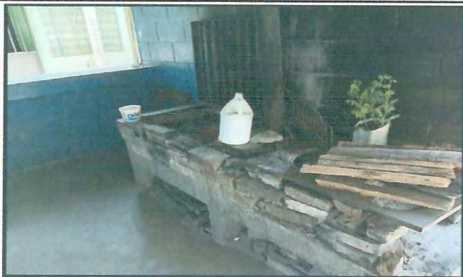
Foto 1: Estado de la cocina
